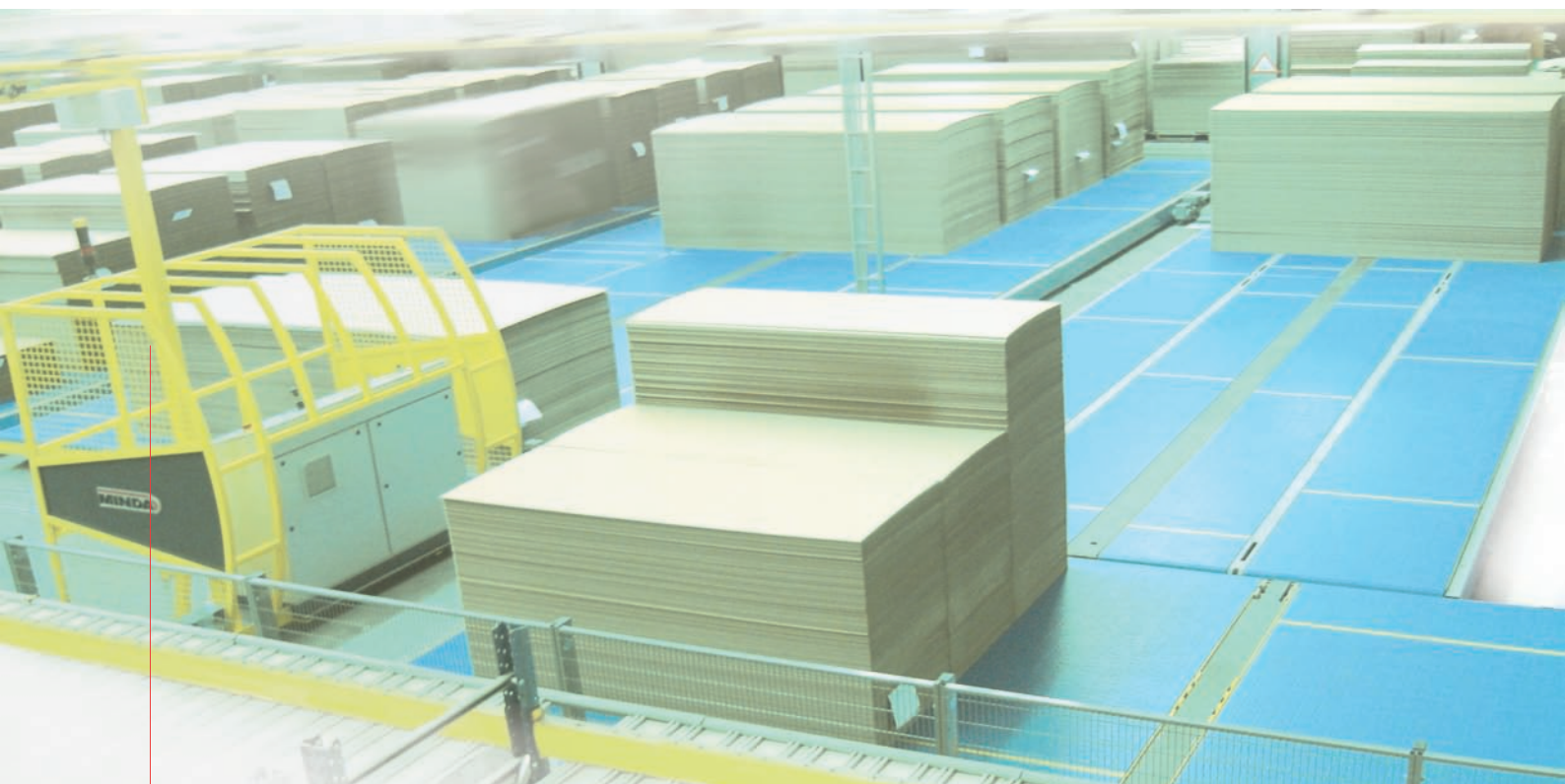
Intermediate storage with plastic chain conveyors Zwischenlager mit Kunststoffkettenförderern
