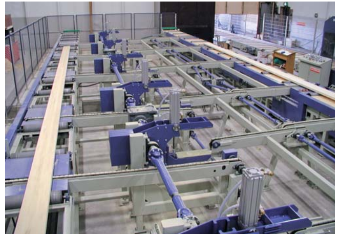
Ausflickstation im Längsdurchlauf: zweiter Ausflickplatz mit vorgelagerter Wendevorrichtung
